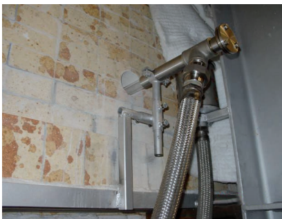
STG-Herdraumdrucksonde installiert
